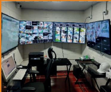
Ampliación con mas de 90 cámaras 2Mp HD, instalación de pantallas 52", actualización de equipos de grabación NVR DAHU2 2MP.
