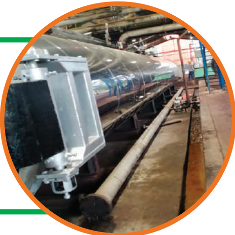
Cambio de tubo para condensado autoclave N°3
