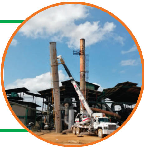
Montaje de nueva chimenea
