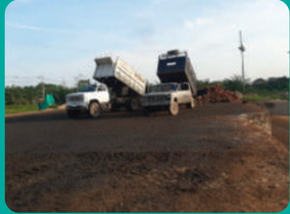
Ampliación de pisos complementarios de la bascula la 4.
