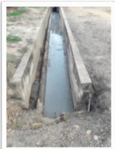
Mejora al sistema de canales de aguas lluvias
