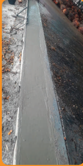
Reparación a la tolva de recepción de fruta
