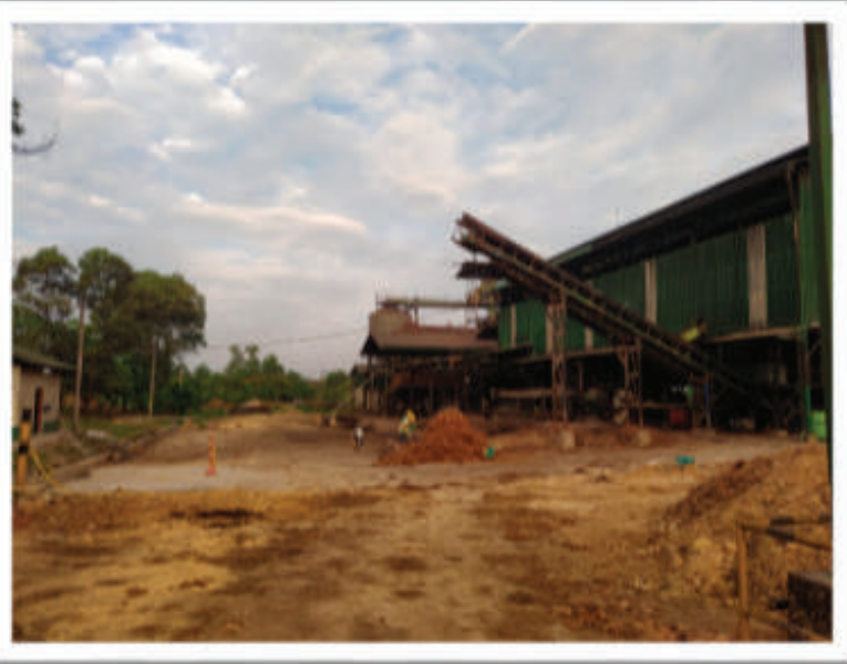
Ampliación de pisos complementarios del patio de raquis
