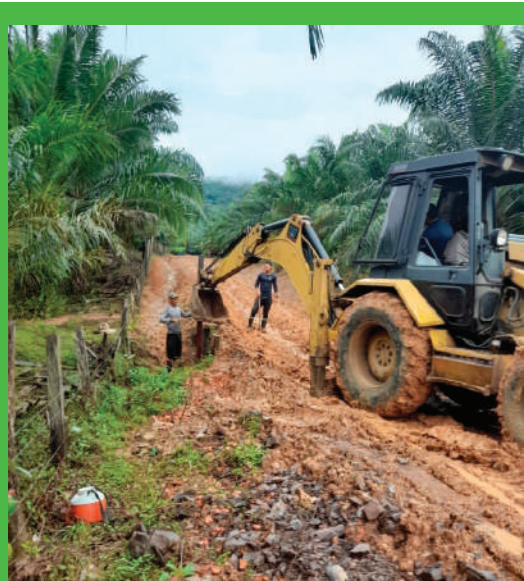
Arreglo de puente entrada a cultivo.
