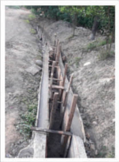
Mejora al sistema de canales de aguas lluvias
