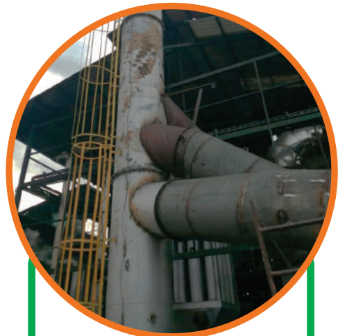
Cambio de ductos de la caldera N°1, filtro de mangas y conexión con la nueva chimenea
