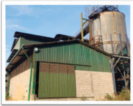
Aumento de la capacidad de almacenamiento de torta
